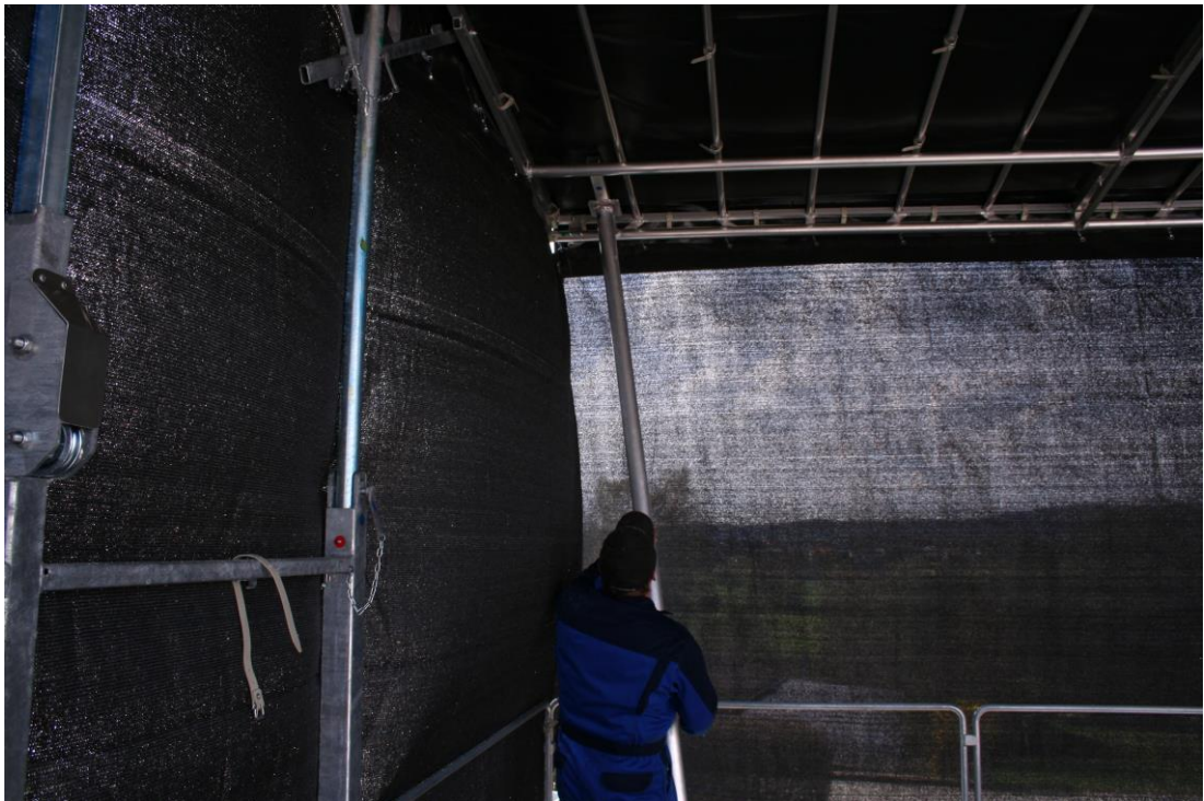
Bild 15 Setzen der hinteren Stützen
