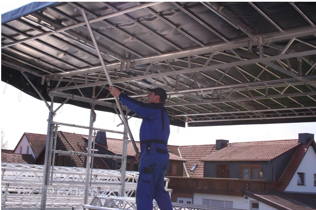
Bild 10 Dachflügel einrasten
