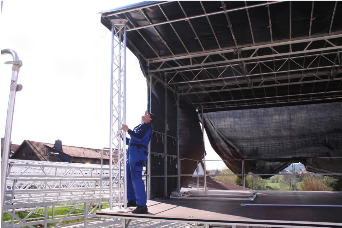
Bild 14 Stützen setzen und eindrehen
