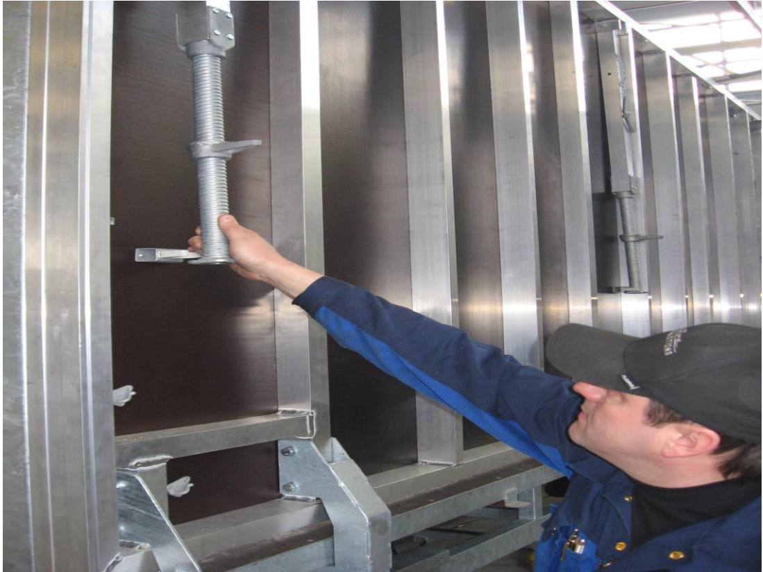
Bild 4 Bodenstützen lösen
