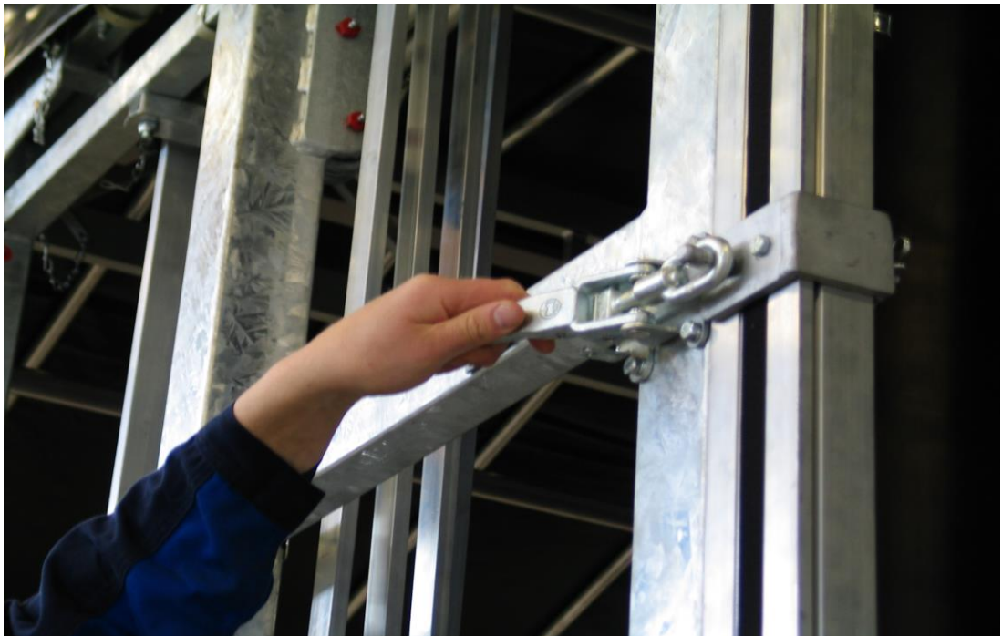
Bild 5 Handhebelverschlüsse öffnen
