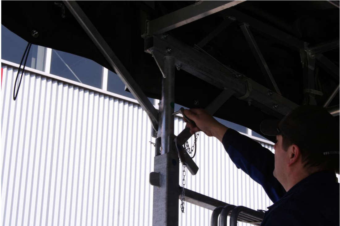
Bild 11 Dachflügel mit grünen Bolzen sichern
