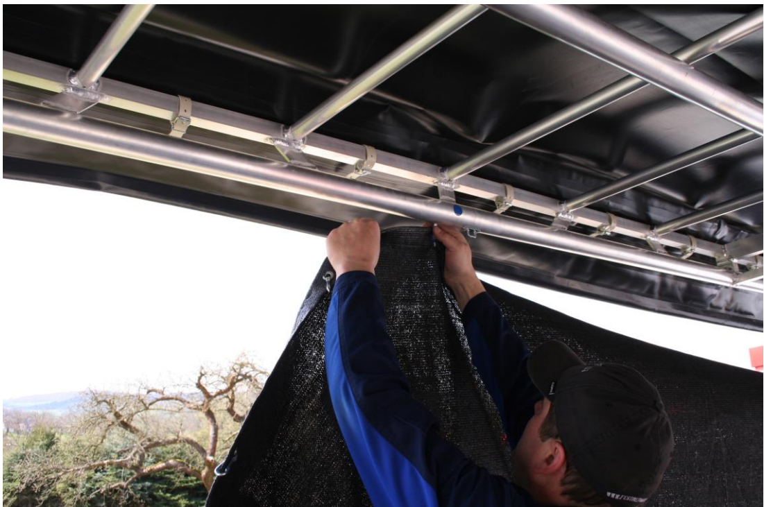
Bild 12 Befestigung der Behänge
